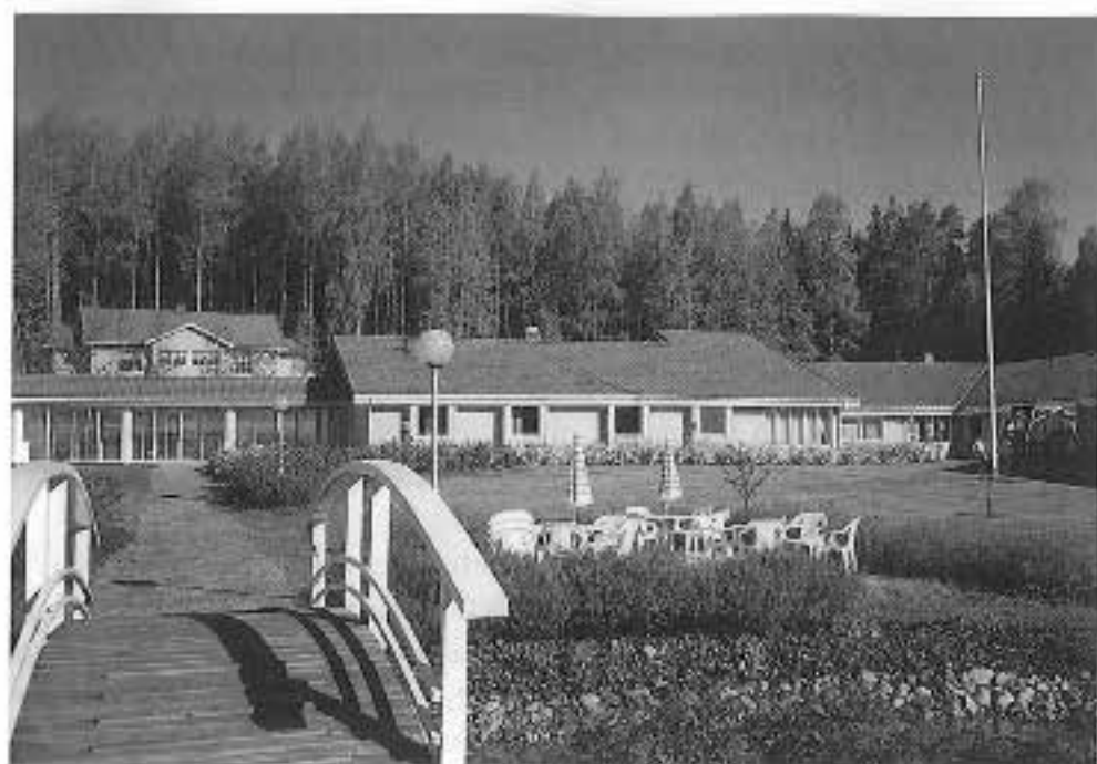
Keikkulan kurssi- ja virkistyskeskuksen rakentamisesta tuli liiton voimannäyte.
